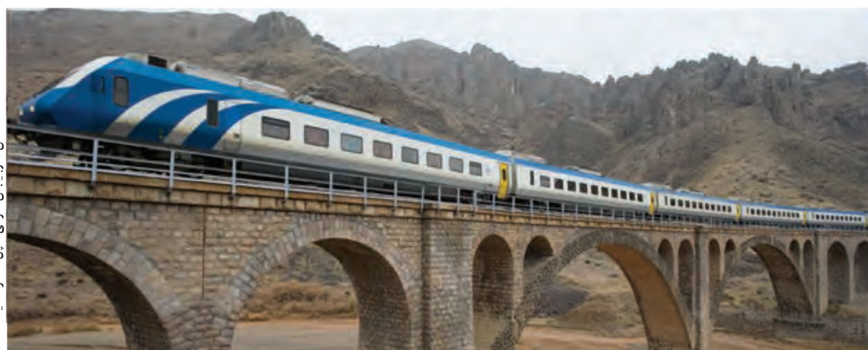
استان آذربایجان شرقی - پل دختر - میانه
